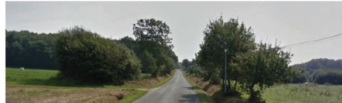
Photo 59 : Vue sur la RD 1 en direction la Trinité-Porhoët
